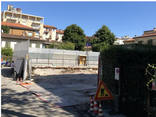
Il cantiere: l'ex scuola è stata demolita in questi giorni
