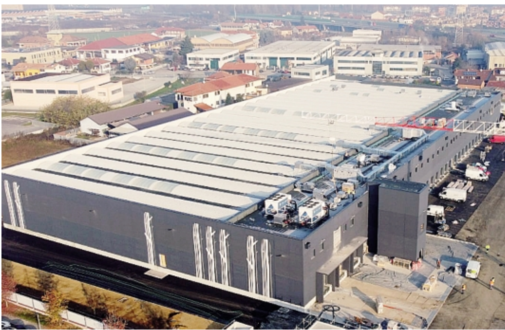
Il nuovo polo logistico della Mazzocco (controllata da Italtrans) a Nichelino costruito a tempo di record
