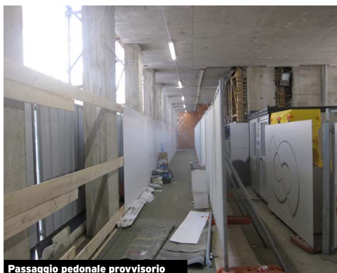
Passaggio pedonale provvisorio
