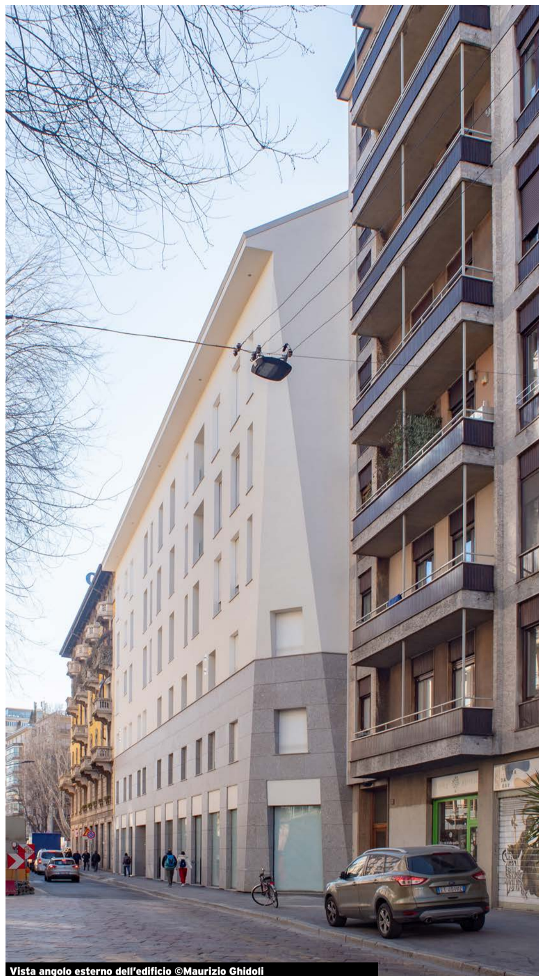
Vista angolare esterna dell'edificio ©Maurizio Ghidoli
