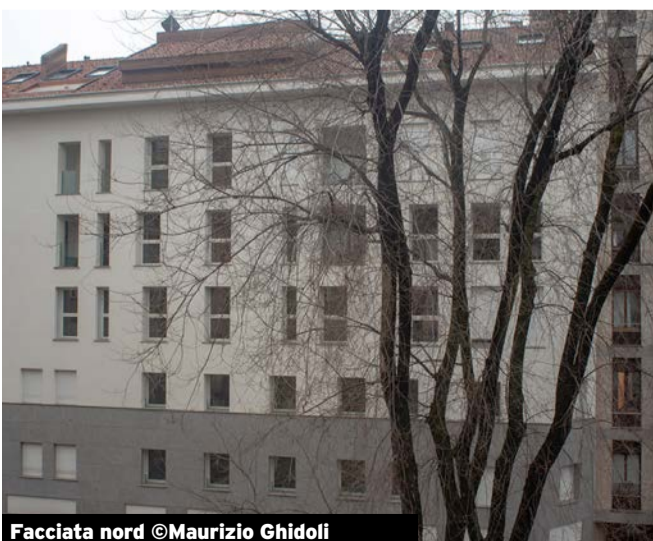
Facciata nord ©Maurizio Ghidoli
