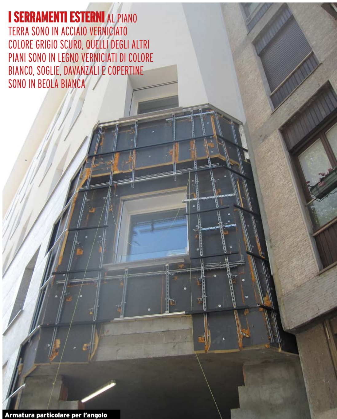
Armatura particolare per l'angolo
